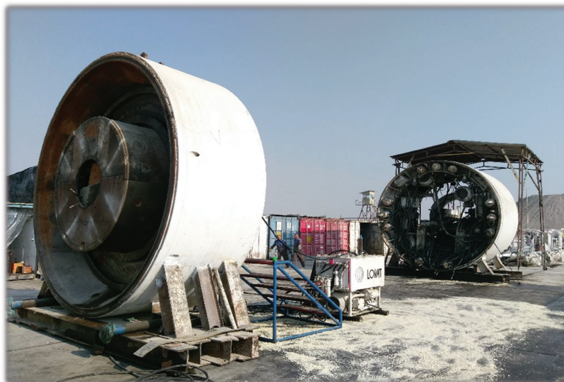
حفاری مکانیزه با استفاده از دستگاه TBM
