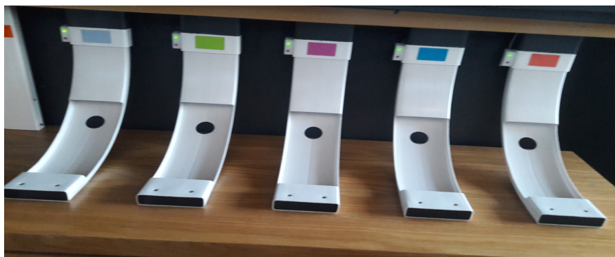
ورودی سیستم پنوماتیک برای انتقال مدارک از کارکنان به اپراتورها در تالار خدمات عمومی
