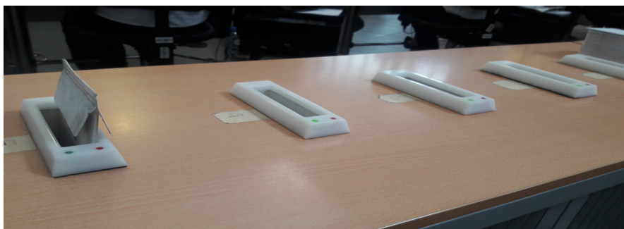
خروجی سیستم پنوماتیک و تحویل مدارک به اپراتورها در تالار خدمات عمومی
